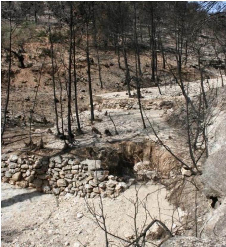
*FOR-2. Muro de bancal parcialmente arrastrado por la corriente de las últimas lluvias. Aguas arriba se aprecia una importante sedimentación de piedras y gravas.*
