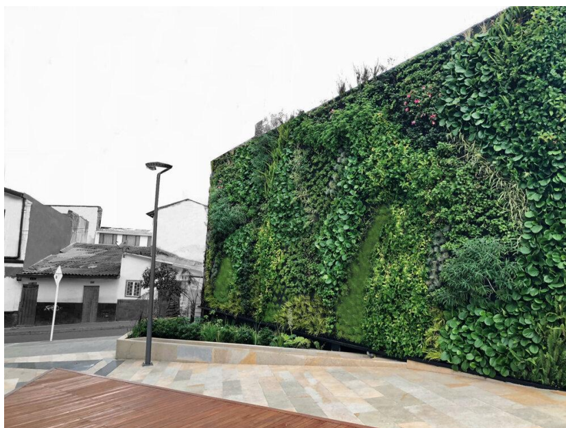
Figura 8. Muro verde en el Edificio Equilibrium en Bogotá. Fuente: sustentar.co
