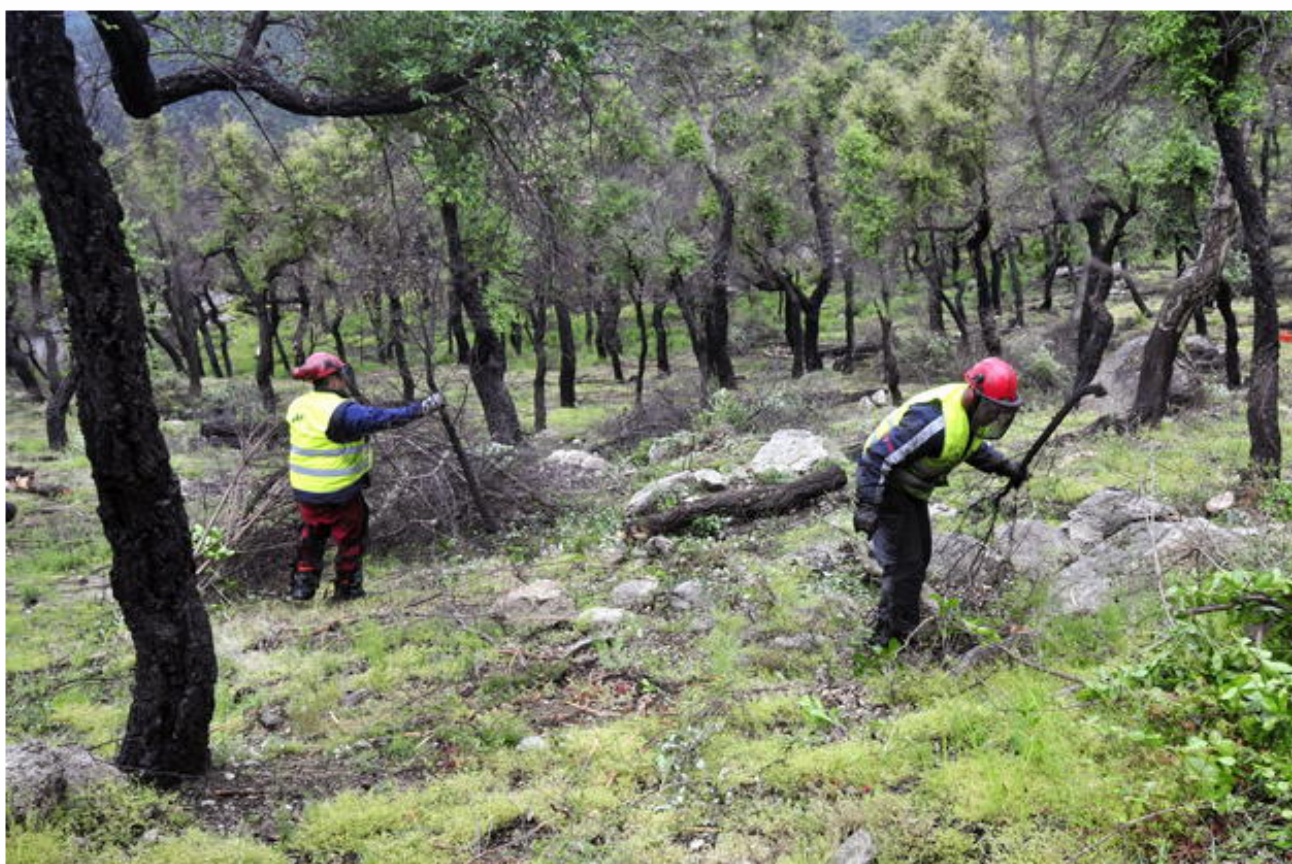
Imagen de archivo de los trabajos de restauración de la región del Alt Empordà. EFE/Robin Townsend
