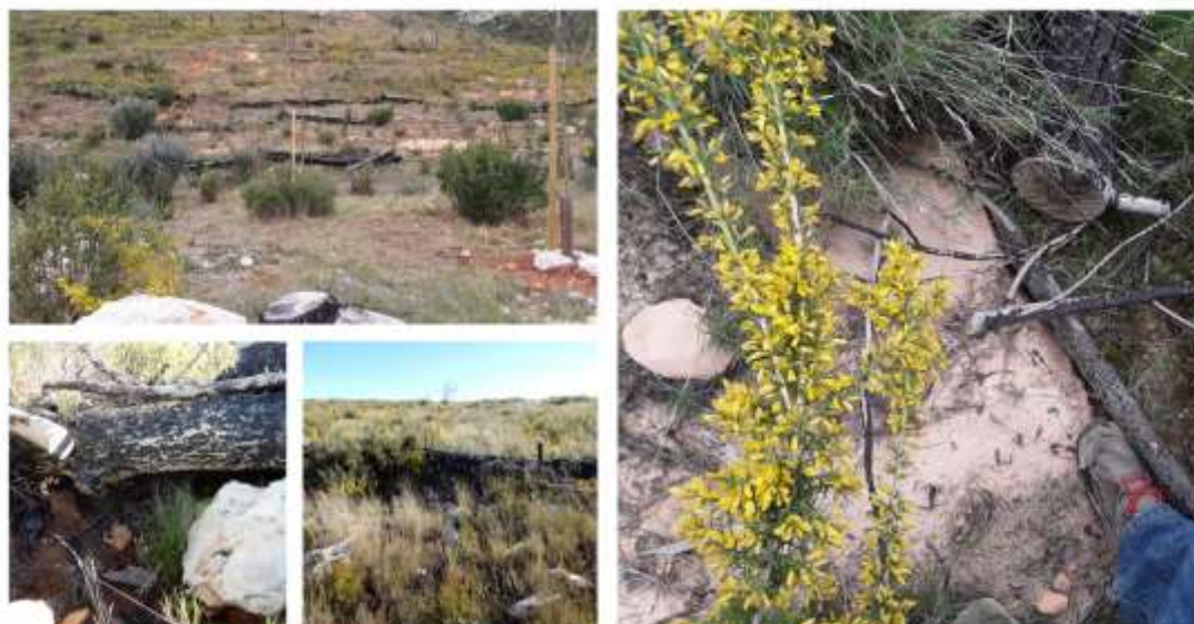
Figura 11. Fajinas para la contención de la erosión realizadas en los meses posteriores al incendio. Arriba a la izquierda, fajinas realizadas en las laderas que vierten al “Barranc de Borrell”; Derecha, sedimentos acumulados en fajinas ubicadas en el “Barranc de Borrell”; Abajo a la izquierda, escaso contacto entre los troncos y el suelo, por lo que no se frena la escorrentía superficial ni se acumulan sedimentos; Abajo centro, fajina realizada en zona de baja pendiente (Febrero de 2021).
